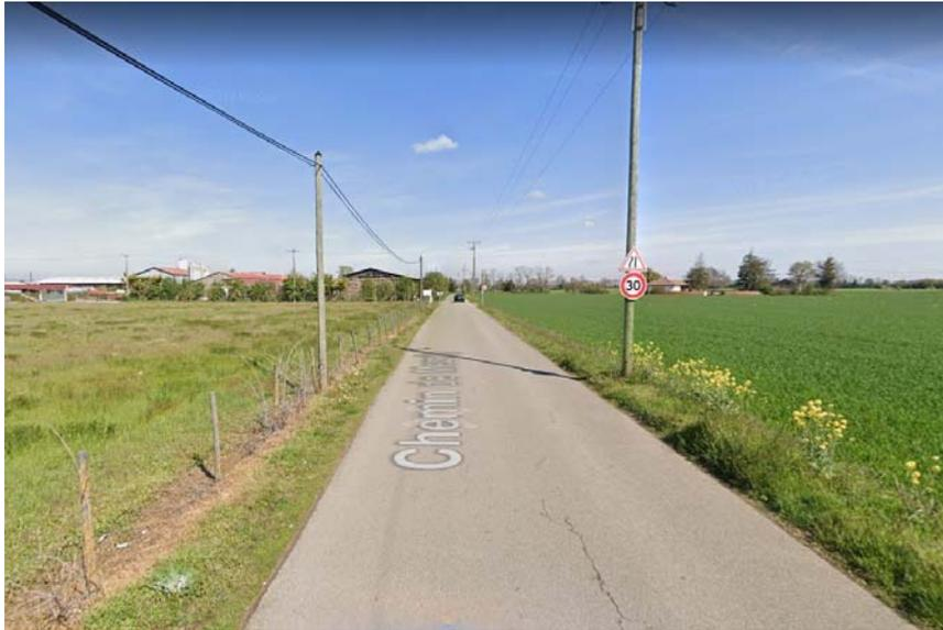
Figure 3 : exemple de chemin rural codé avec une vitesse de 50 km/h et une capacité de 800 UVP/h/sens
